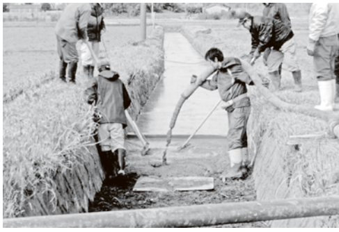
用水路底辺部のコンクリート化
